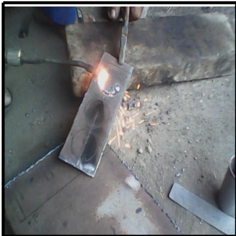
Pelubangan Dudukan Cetakan
