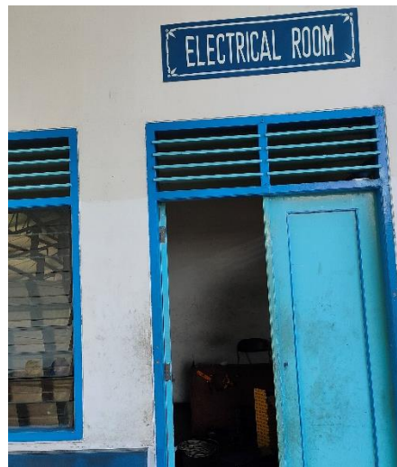
Gambar 3. 27 Ruang Elektro (sumber: PT Gudang Garam Tbk Kediri)
