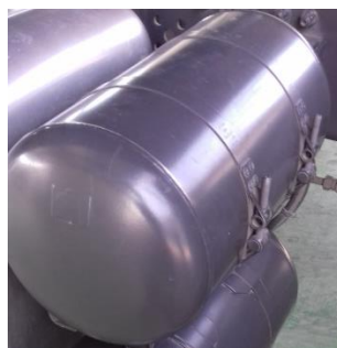
Gambar 4. 3 Reservoir udara Sumber: PT Gudang Garam Tbk. Kediri, 2020
