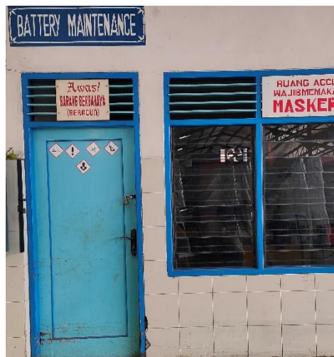
Gambar 3. 30 Ruang Pemeliharaan Baterai (sumber: PT Gudang Garam Tbk Kediri)
