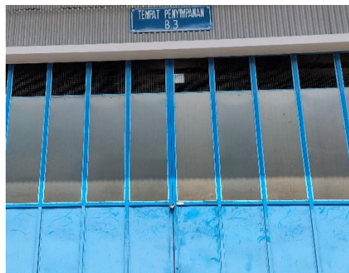
Gambar 3. 32 Ruang Penyimpanan B3 (sumber: PT Gudang Garam Tbk Kediri)
