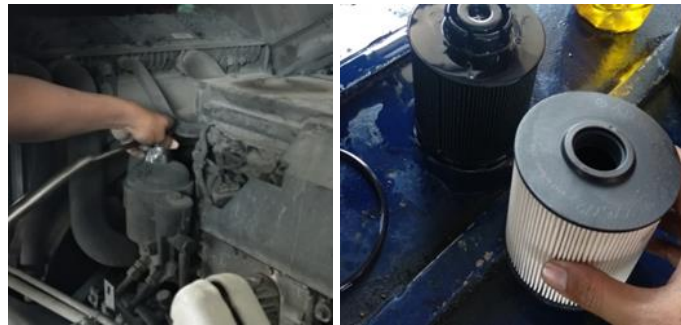
Gambar 3. 4 Penggantian Filter Oli dan Filter Solar (sumber: PT Gudang Garam Tbk Kediri)
