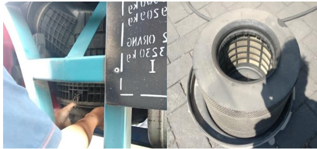
Gambar 3. 7 Pembersihan Filter Udara (sumber: PT Gudang Garam Tbk Kediri)
