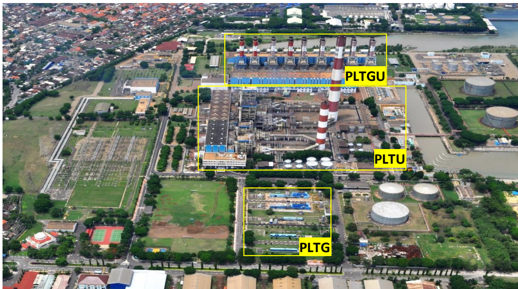
Gambar 1.2 Unit Pembangkit PLTG PLTU PLTGU PT. PJB UP Gresik Sumber : PT PJB Gresik
