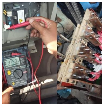
Gambar 3. 3 Megger Test
