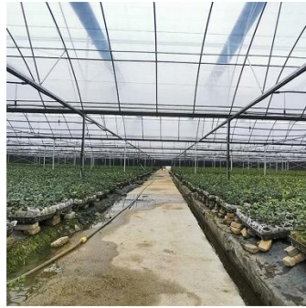
Gambar 1. 1 Permukaan greenhouse yang tidak rata
