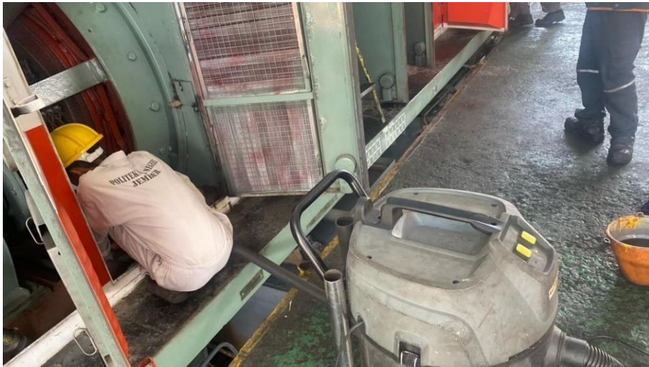
Pembersihan ruang main generator
