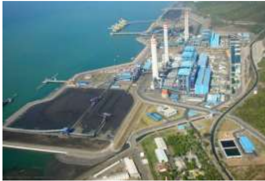
Gambar 2. 1 PLTU Paiton Unit 3, 7 & 8
