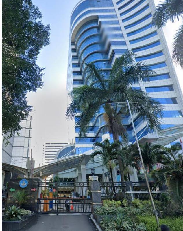
Gambar 1. 2 Gambar Gedung D Tampak Samping
