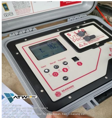
Gambar 4.26 Quality Control pada Commisioning Test (Sumber: ATW Solar)
