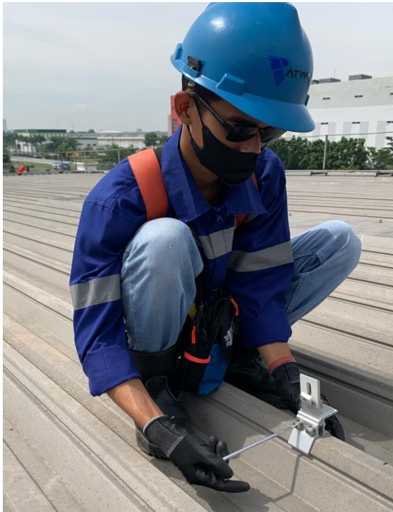
Gambar 4.29 Pemasangan Mounting KlipLok menggunakan Kunci L 6mm
