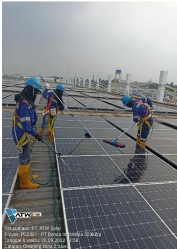
Gambar 5.1 Cleaning Maintenance (Sumber: Data Primer Diolah 2022)
