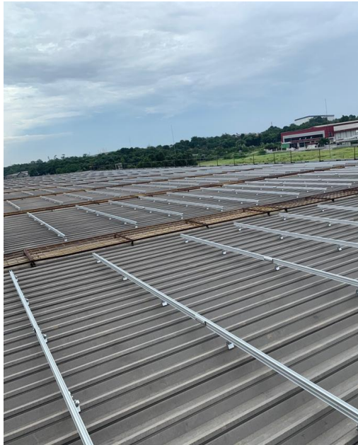
Gambar 4.22 Kegiatan Pekerjaan Instalasi Sistem Mounting ( Sumber: ATW Solar )
