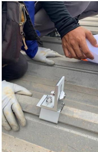
Gambar 4. 14 Pengaplikasian kliplok pada atap (Sumber: ATW Solar)
