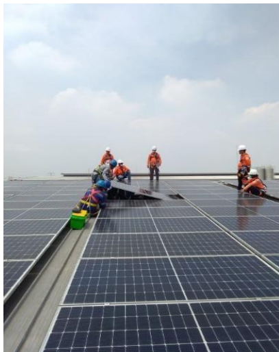
Gambar 5.5 Pergantian Panel Surya (Sumber: Data Primer Diolah 2022)
