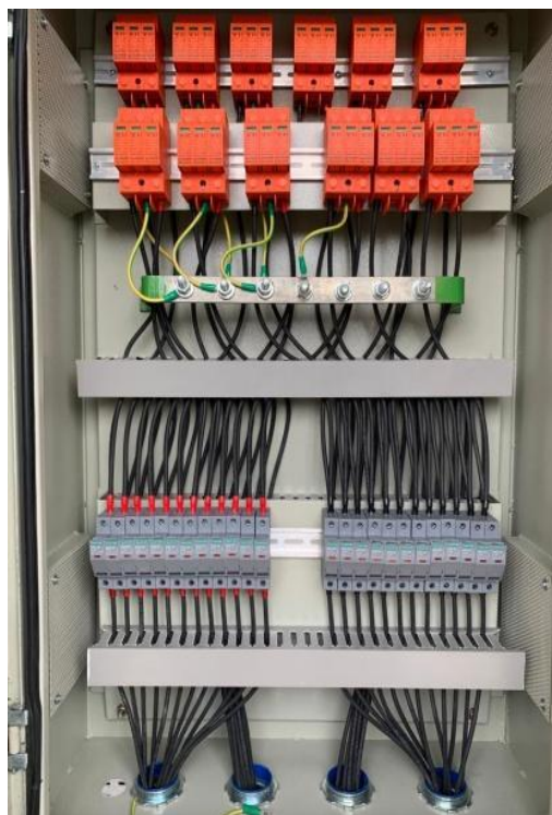
Gambar 4.24 Pemasangan Instalasi Panel DC Combiner (Sumber: ATW Solar)
