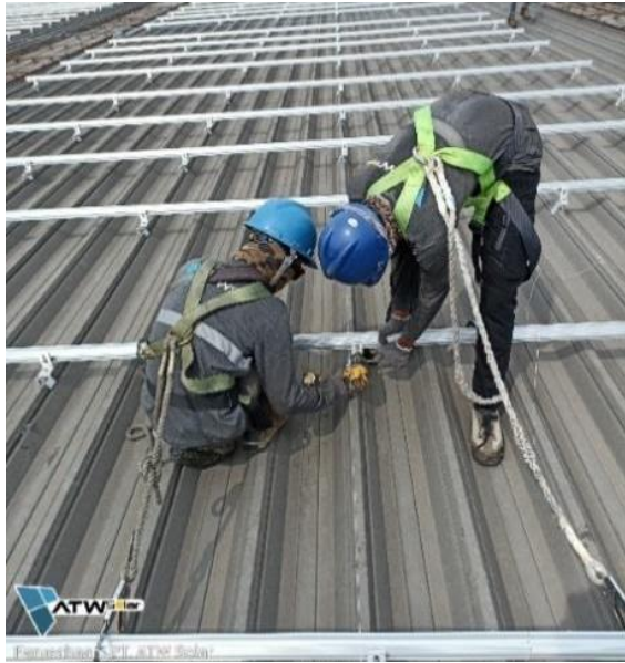
Gambar 4.34 Pemasangan Railudukan Panel Surya (Sumber : ATW Solar)
