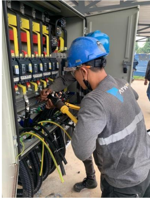
Gambar 4.25 Pemasangan Instalasi Panel AC Combiner (Sumber: ATW Solar)
