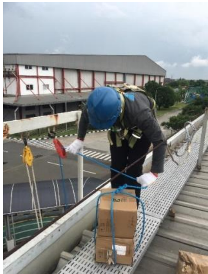
Gambar 4.31 Pengangkatan Mounting sistem ke Atap (Sumber: ATW Solar)
