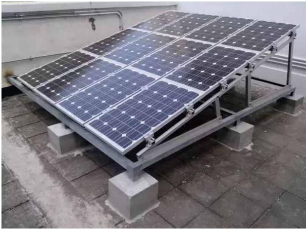
Gambar 4.11 Pemasangan Panel Surya Model Pondasi Balok (Sumber: Hexamitra.co.id )
