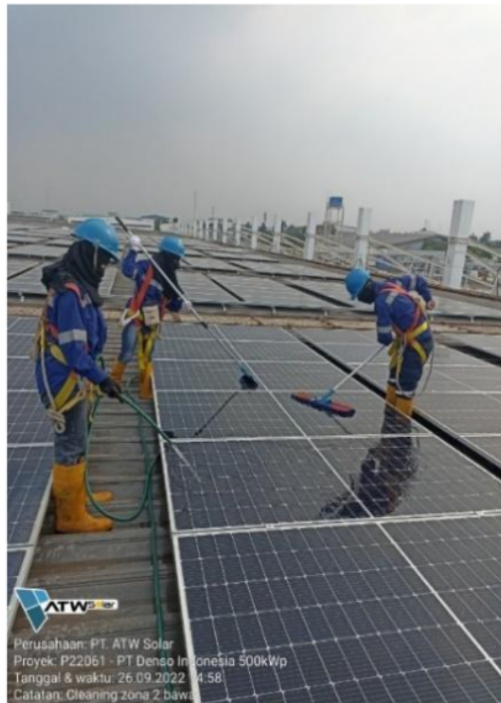
Gambar 5.1 Cleaning Maintenance (Sumber: Data Primer Diolah 2022)
