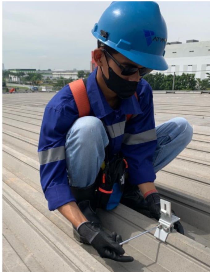
Gambar 4.29 Pemasangan Mounting KlipLok menggunakan Kunci L 6mm
