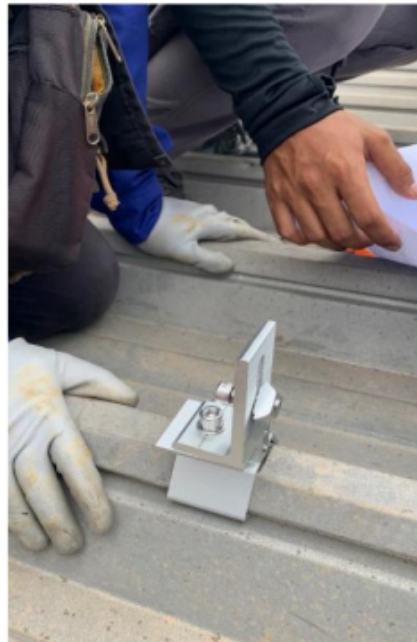
Gambar 4. 14 Pengaplikasian kliplok pada atap (Sumber: ATW Solar)
