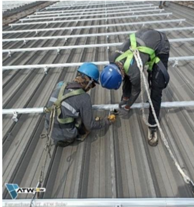
Gambar 4.34 Pemasangan Railudukan Panel Surya (Sumber : ATW Solar)
