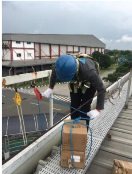
Gambar 4.31 Pengangkatan Mounting sistem ke Atap (Sumber: ATW Solar)
