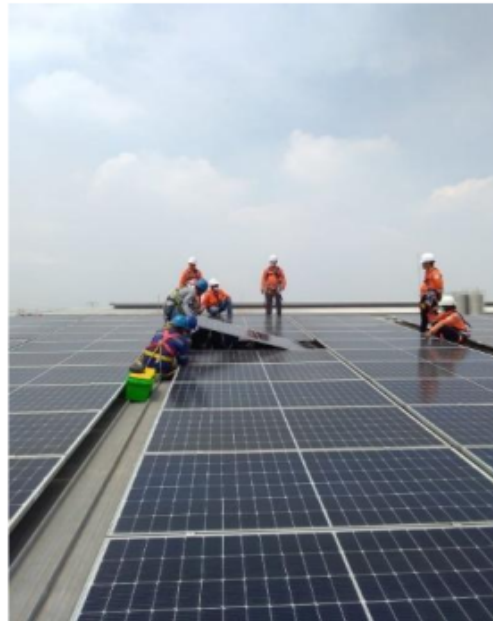
Gambar 5.5 Pergantian Panel Surya (Sumber: Data Primer Diolah 2022)
