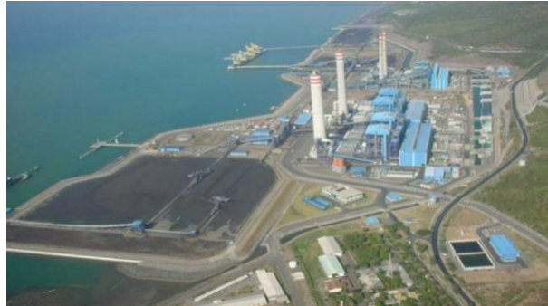
Gambar 2.1 PLTU Paiton Unit 3, 7 & 8
