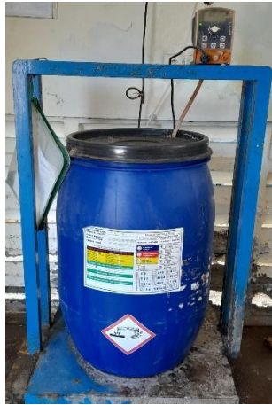
Gambar 3.13 Tong NaOCl (Sumber: Dokumen Pribadi,2022)
