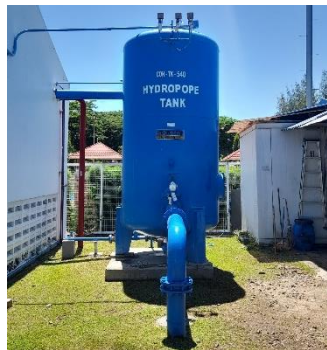
Gambar 3.15 Hydropope tank (Sumber: Dokumen Pribadi,2022)
