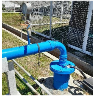
Gambar 3.11 Pompa Sumur Deepwell (Sumber: Dokumen Pribadi,2022)
