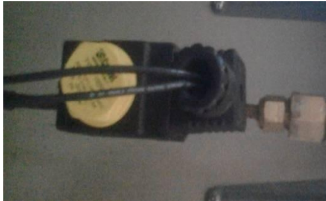
Gambar 6. Katup Solenoid
