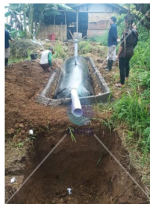
Gambar 5. Saluran Outlet
