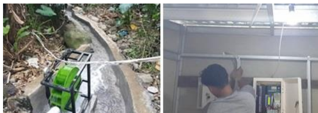
Gambar 8. Pemasangan mikrohidro dan sinkronisasi aliran listrik dari tiga mikrohidro
