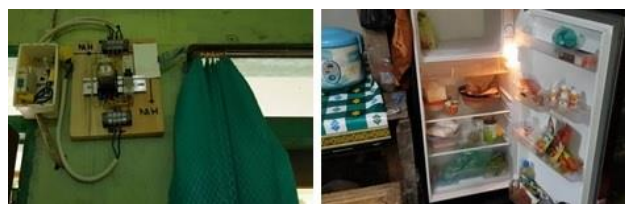
Gambar 9. Hasil instalasi listrik Dusun Lanasan
