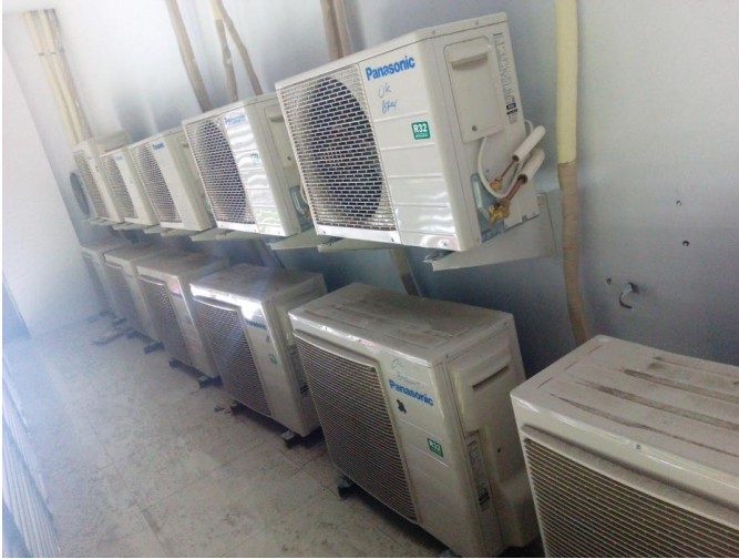
Gambar 8: Penempatan kondensor AC Gedung Teknik.
