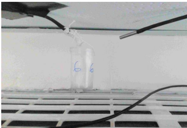
Gambar 3: Pemasangan sensor suhu udara sebelum memasuki evaporator
