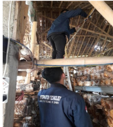
Gambar 5. Pemasangan selang dan nozzle pengembunan kumbung jamur
