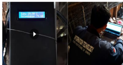
Gambar 6. Pengecekan pembacaan sensor suhu dan kelembaban
