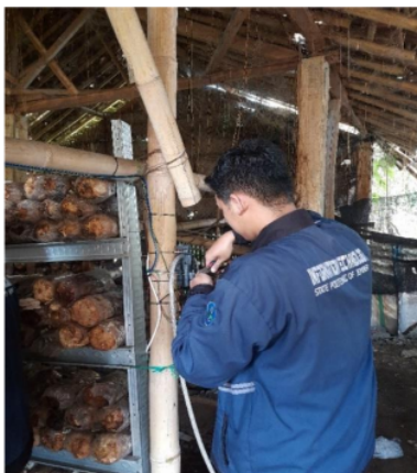
Gambar 4. Pemasangan alat kontrol suhu
