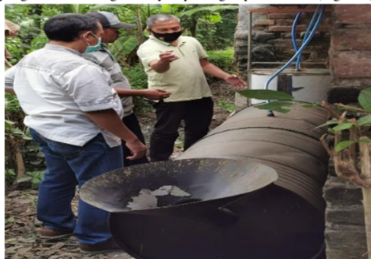
Gambar 2. Pelatihan instalasi biogas
