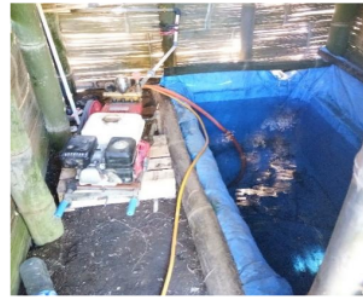
Gambar 6. Perbaikan instalansi pengairan untuk lahan demplot pengabdian
