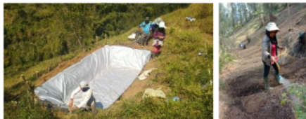
Gambar 6. Perbaikan instalansi air
