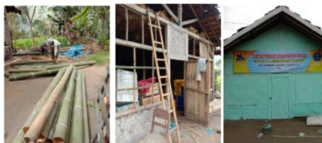
Gambar 9. Proses perbaikan dalam gudang pasca panen untuk rak dan sanitasi
