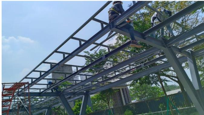
Gambar 3.6 Melakukan Pembuatan *Mounting* Panel Surya
