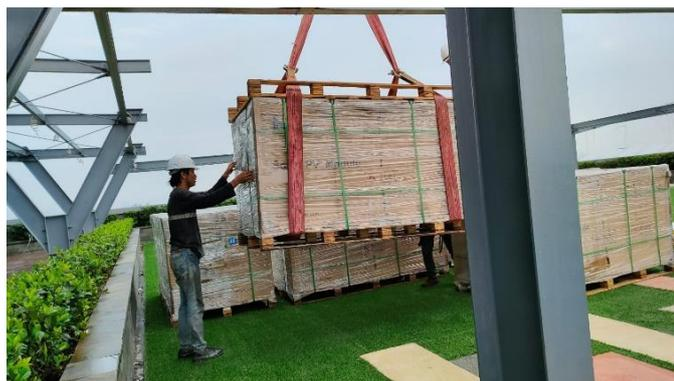
Gambar 3.7 Melakukan *Lifting* Panel Surya
