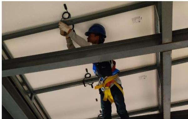
Gambar 3.9 Melakukan *Connecting* Kabel MC-4 pada Panel Surya
