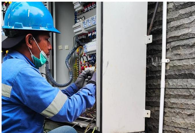
Gambar 3.12 Melakukan *Connecting* Kabel AC ke LVMDP
