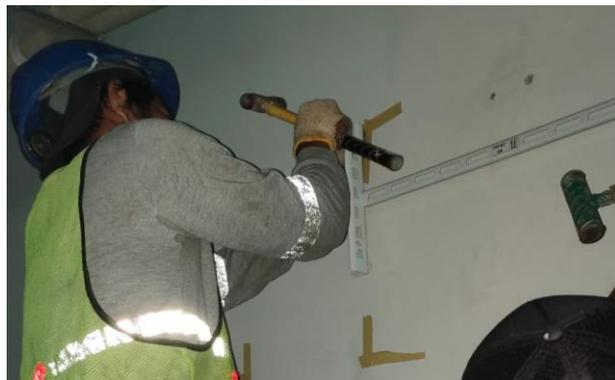
Gambar 3.10 Melakukan Pemasangan *Bracket*
