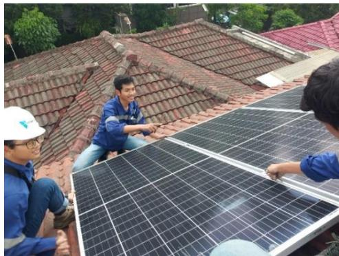
Gambar 3.14 Pelepasan dari panel surya
