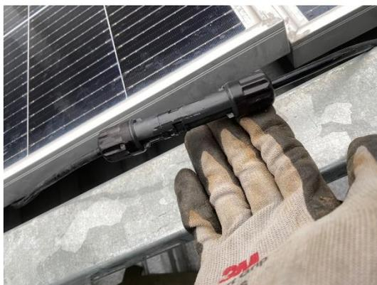
Gambar 3.7 Perbaikan kabel DC (MC4)
