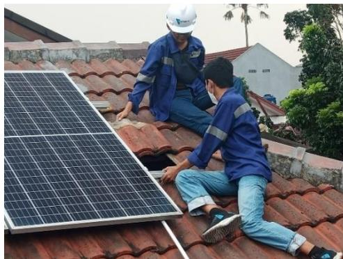
Gambar 3.15 Pemasangan *Bracket* kembali dengan kencang
