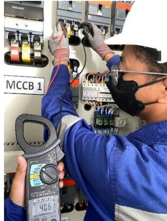
Gambar 3.8 Pengukuran Tegangan AC tiap fasa
