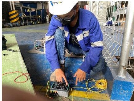
Gambar 3.9 Pengukuran *Grounding*
