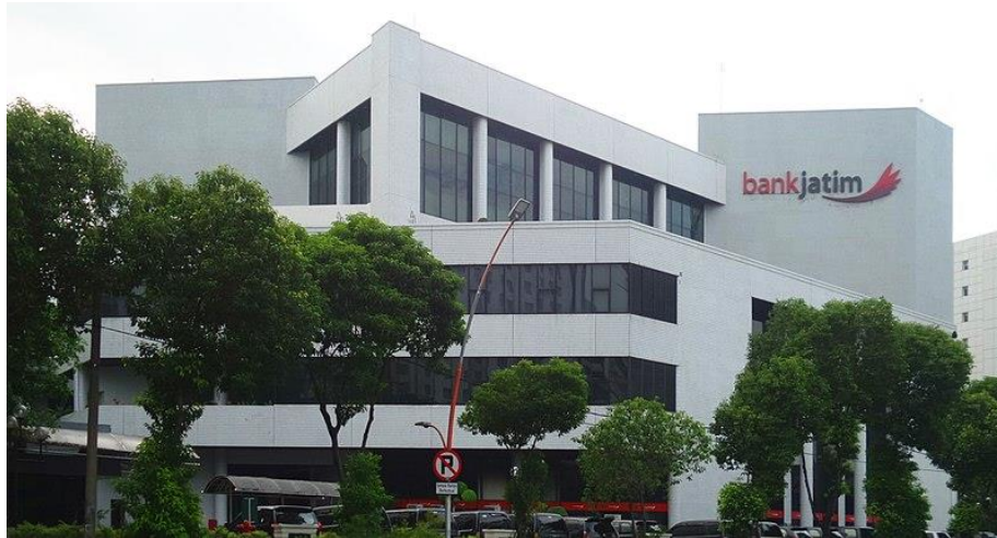
Gambar 1 2 Foto Gedung Kantor Pusat Bank Jatim
