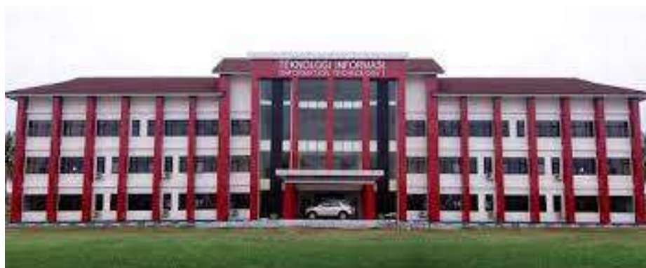
Gambar 1.2 Gedung Teknologi Informasi
