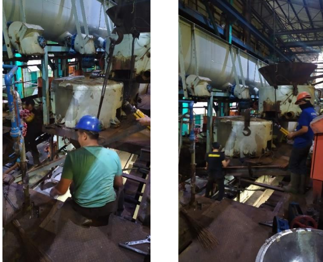
Gambar 5.10 proses perbaikan pondasi
